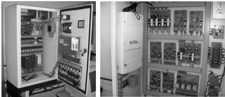
Fig. 5. Reconfiguración e instalación de los equipos de control del sistema
