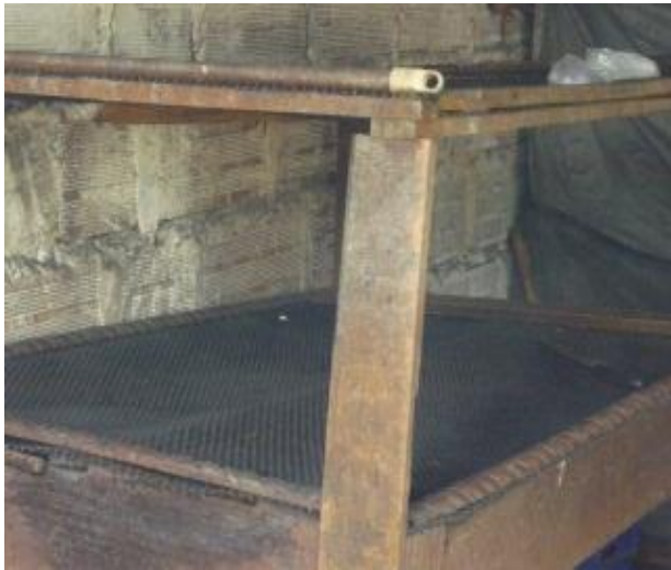
Estante de enfriamiento
