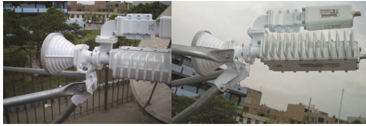
Figura 33. ODU en soporte
