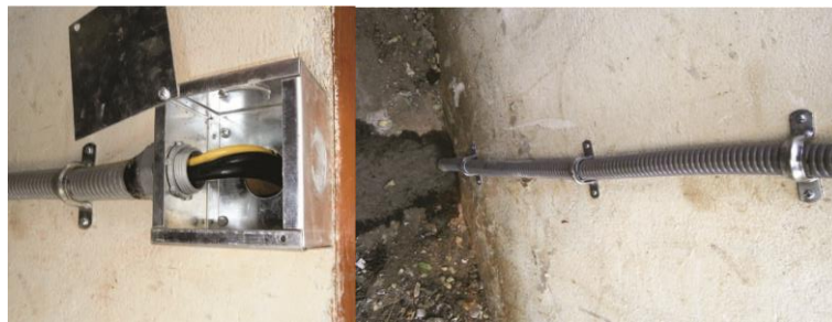
Figura 34. Adecuación del Cable
