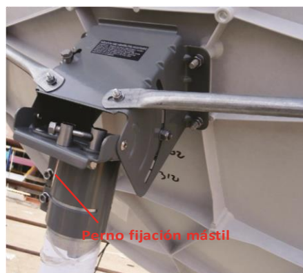
Figura 29. Fijación al Mástil
