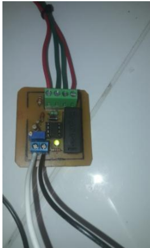
Figura 36. Montaje físico Termocupla.
