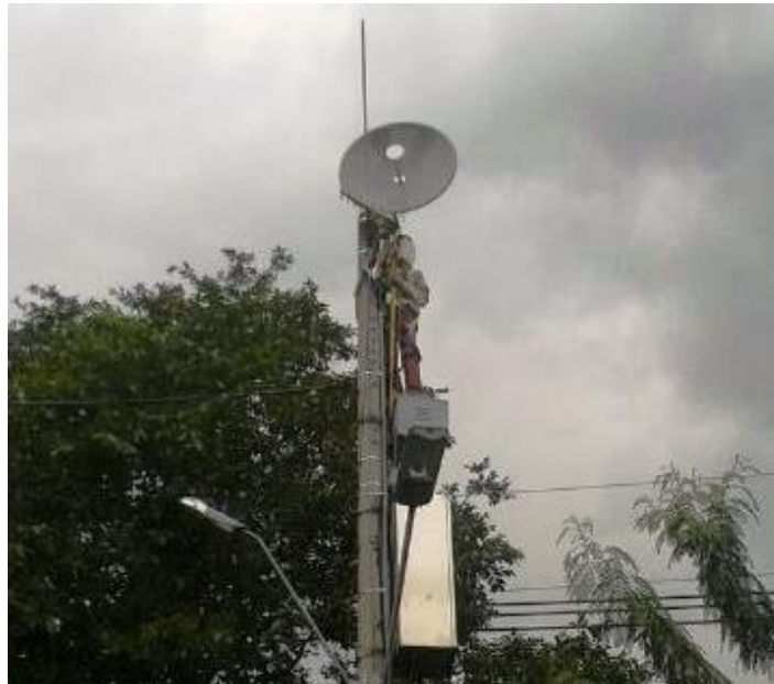
Figura 9. Contratista realizando pruebas de campo con equipos RADWIN.
