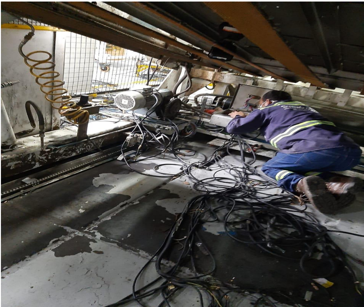
Cambio de cableado stacker automático.
