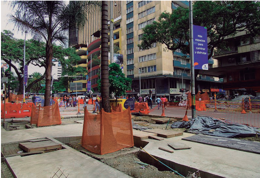
https://commons.wikimedia.org/wiki/File:2018_Medell%C3%ADn_reparaci%C3%B3n_andenes_avenida_La_Playa_frente_al_edificio_de_Coltejer.jpg Autor: Felipe Restrepo Acosta.
