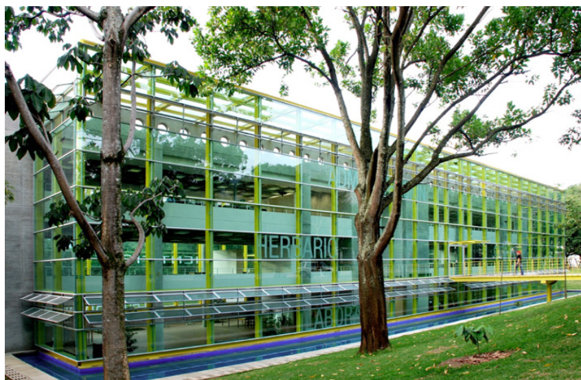
Edificio científico. Fotografía: cortesía de la periodista Pilar Velilla.
