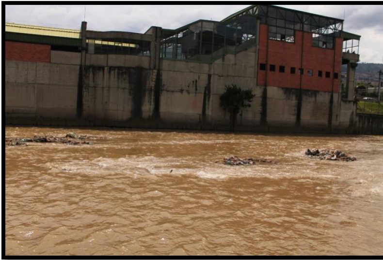
Figura 16. Pequeñas islas de escombros y basura entre el río (2022). Fotografía digital, Evelin Polo. Fotografía tomada durante el recorrido.
