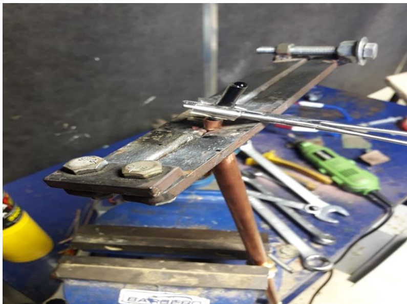
Fig. 46. Estrangulación del umbilical después de llenado el termosifón. Fuente: Elaboración propia.
