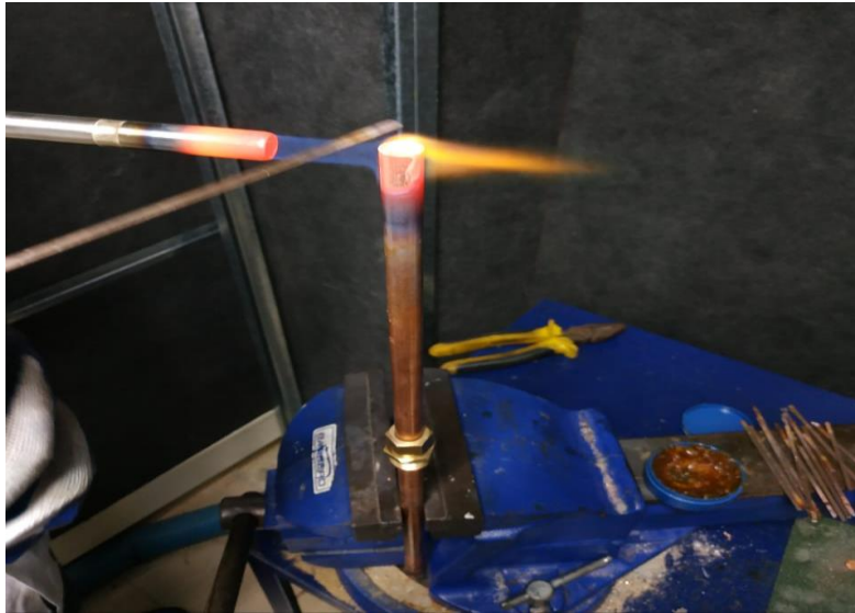
Fig. 30. Piscina de soldadura. Fuente: Elaboración propia.
