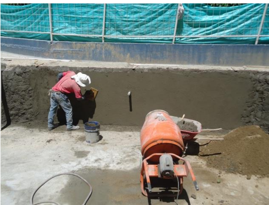
Se Revoca con mortero impermeabilizado
