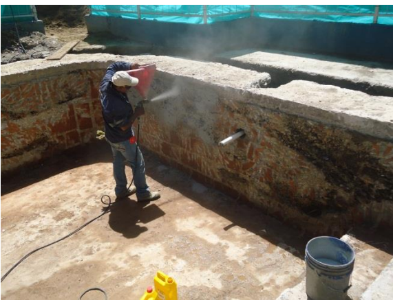
Se impermeabilizó por completo la piscina
