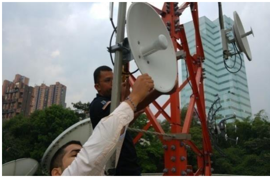
Figura 24. Instalación de Antena en Torre Azotea Teledellín.
