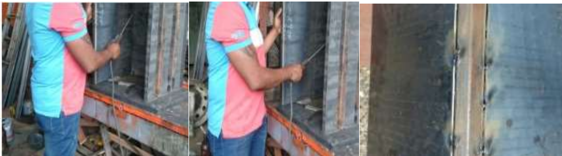
Figura 20. Soldadura de la estructura de la máquina compactadora.
