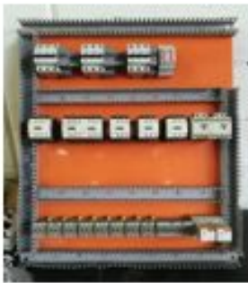
Montaje Tablero Control
