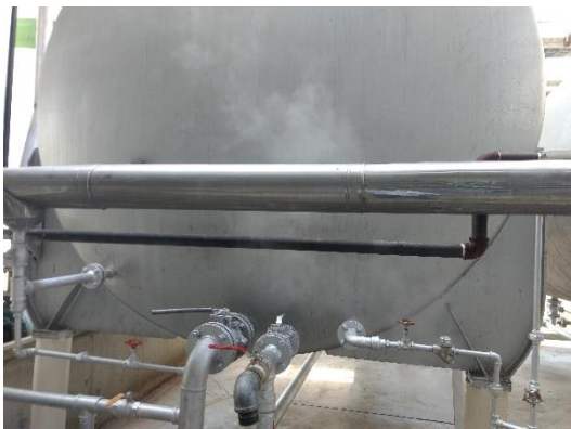
Ilustración 49. Condiciones iniciales del tanque 01, fotografía del autor.
