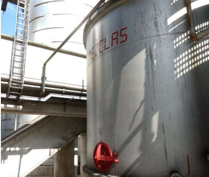
Ilustración 40. Condiciones iniciales del tanque de mezclas, fotografía del autor.
