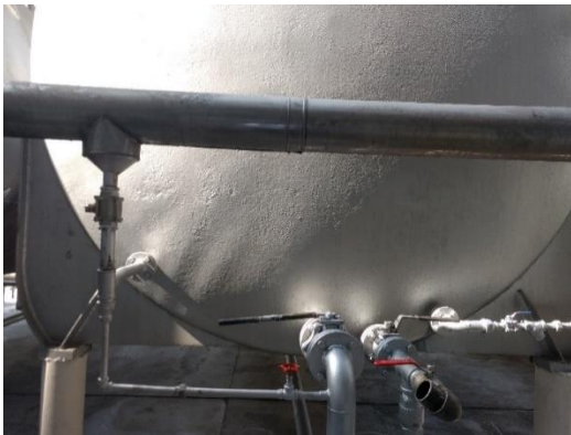
Ilustración 59. Condiciones iniciales del tanque 06, fotografía del autor.
