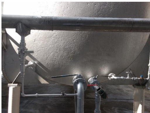
Ilustración 61. Condiciones iniciales del tanque 07, fotografía del autor.
