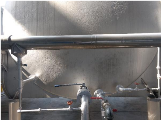
Ilustración 53. Condiciones iniciales del tanque 03, fotografía del autor.
