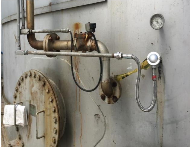
Ilustración 34. Condiciones actuales para el sensado de temperatura en el tanque 1, fotografía del autor.
