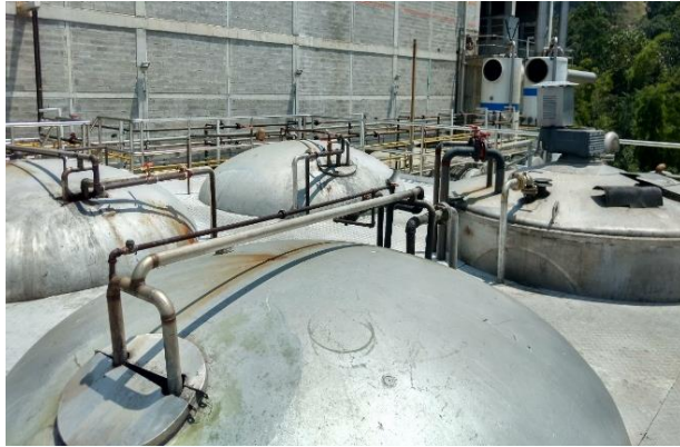
Ilustración 43. Condiciones iniciales de los tanques verticales, fotografía del autor.
