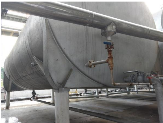
Ilustración 55. Condiciones iniciales del tanque 04, fotografía del autor.
