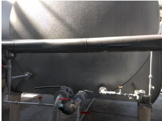
Ilustración 51. Condiciones iniciales del tanque 02, fotografía del autor.
