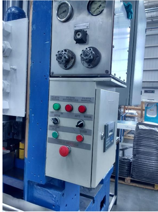
Figura 17. Gabinete de control y válvulas reguladoras de presión.
