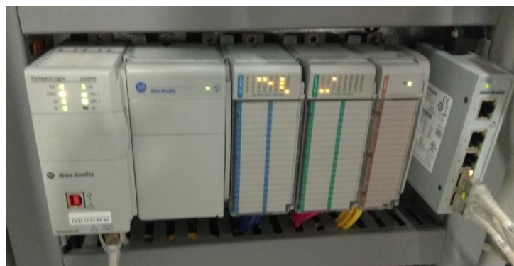
Figura 7. Controlador PLC (Imagen propia autoría, tomada después del montaje de tableriar el control, CIA Noel, Medellín 2017)
