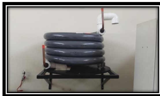
Figura 56 Instalación accesorios para intercambiador
