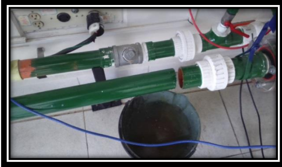
Figura 48 Intervención módulo de tanques
