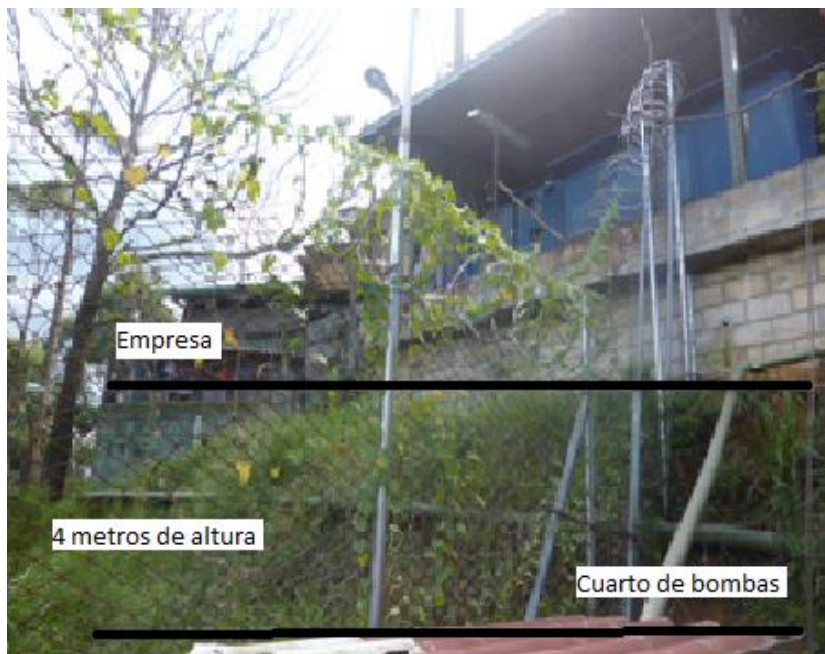
Figura 67. Altura de impulsión. Fuente: (propia).
