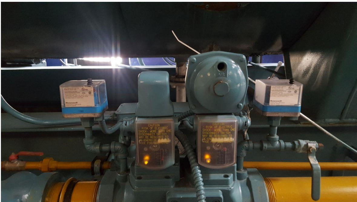
Figura 4. Aspecto del presóstato de la caldera pirotubular Postobón S.A. Sede Guayabal (Fuente: autores)
