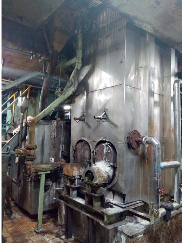
Ilustración 23. Tanque Soda Caustica
