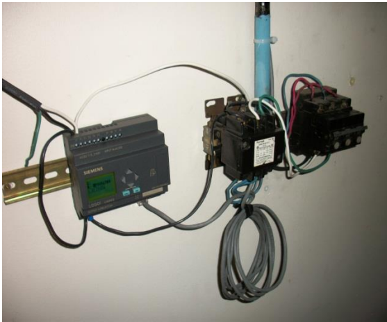
Figura N.4.4.3. 2. PLC esclavo y conexión a contactores.
