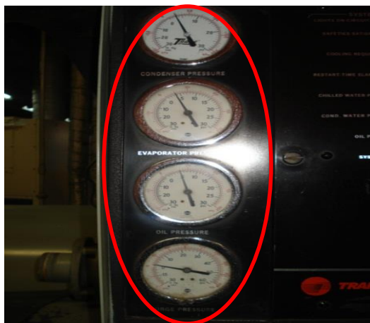
Figura N.4.2. 14. Instrumentos de medición y control malos
