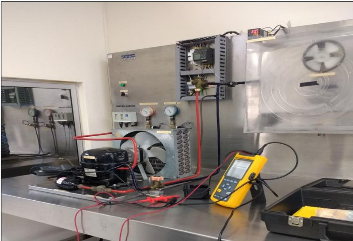
Figura 8. Banco actual de aire acondicionado ITM. Fuente propia
