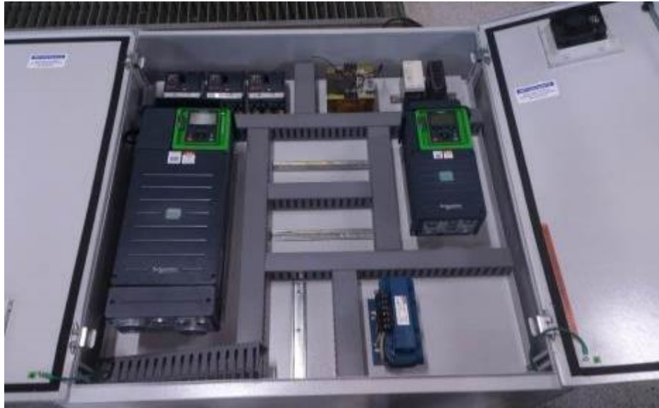
Figura 41. Inicio de ensamblaje de elementos en gabinete eléctrico. Fuente: Elaboración propia.
