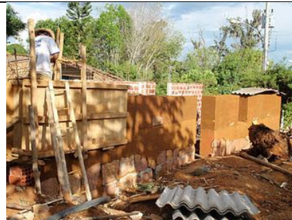
Figura 14. Proceso de construcción de los muros de tapia. Recuperado de Tapia pisada, técnica que se resiste a desaparecer, Agencia de Noticias UN., 2015.
