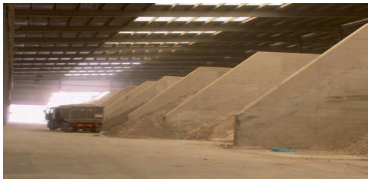
Ilustración 8 Nave cubierta para el almacenamiento de materias primas (fuente: Monfort, 2011)
