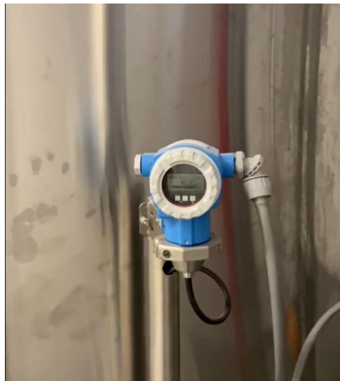
Imagen 8. Sensor de flujo en el sistema de recepción de grasa vegetal. (Fuente: Elaboración propia).
