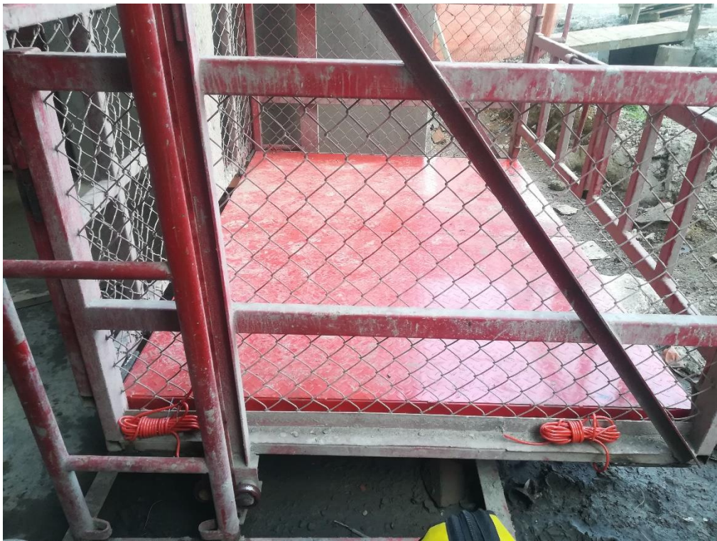
Figura 20: celdas de carga y plataforma de cargue. (Propia)
