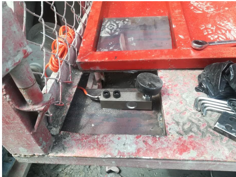
Figura 21: celda de carga en esquina de cabina de malacate. (Propia)
