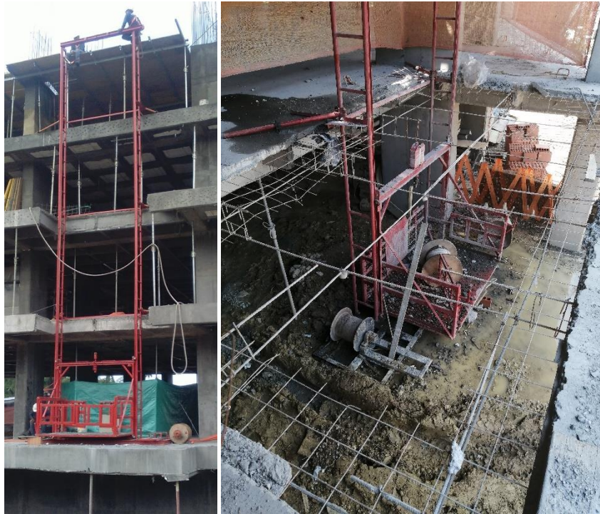
Figura 4: malacates de uso exterior y portátil montados en dos diferentes espacios de trabajo dentro de las obras de Constructora Capital. (Propia)
