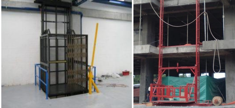
Figura 2: Derecha, malacate para interiores, izquierda, malacate para exteriores. (Ingenieria, 2016)
