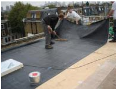
Imagen 28 Colocación de membrana de EPDM en techo
