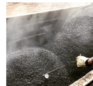
Figura 5. Incorporación de residuos de la industria del cuero en modificación del asfalto
