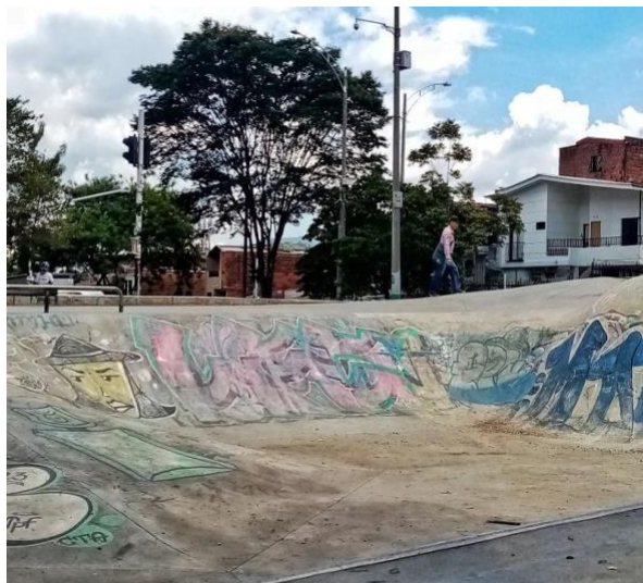
Fotografías tomadas por Ospina. A (2024) Salida de campo reconocimiento del muro a intervenir. skatepark Madre Laura
