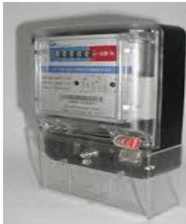
Figura 9. Medidor monofásico trifilar (10)
