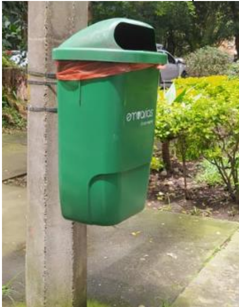
Imagen 22 Deterioro de los botes de basura en polietileno de alta densidad
