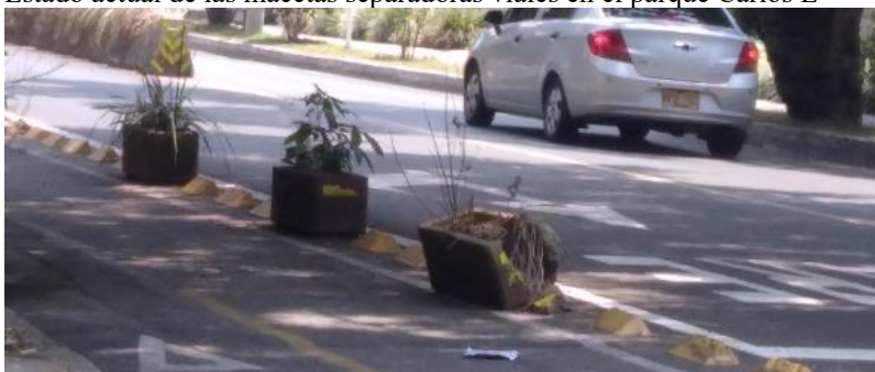
Imagen 19 Estado actual de las macetas separadoras viales en el parque Carlos E
