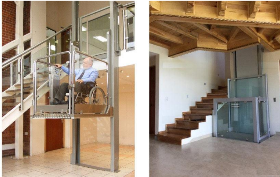
Figure 5 Ascensor de Personas Discapacitadas o con Movilidad Reducida. Fuente: Coldesa 2023
