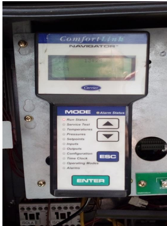
Figura 10. Periférico Navigator Carrier, interfaz para hacer control del equipo.
