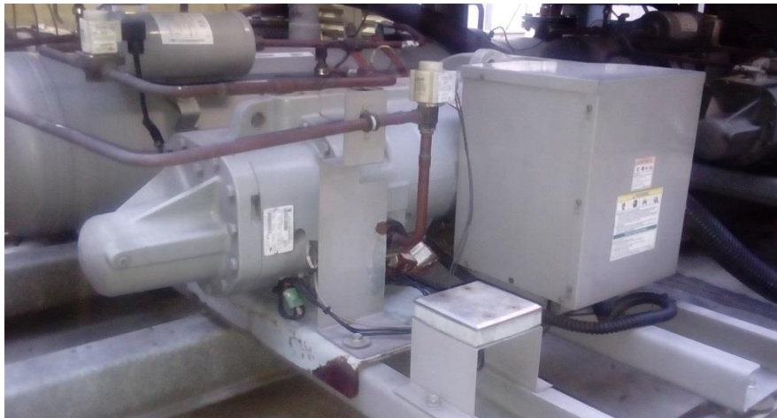
Figura 5. Compresor de Tornillo de Chiller.
