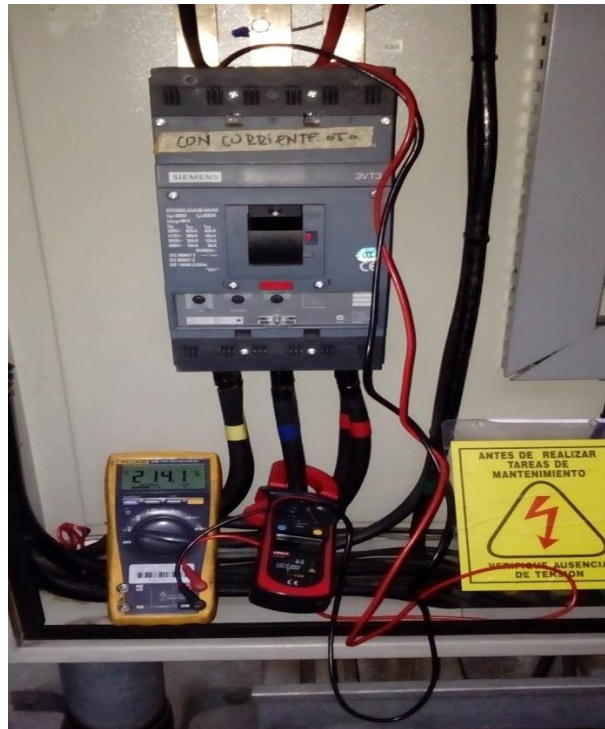
Figura 18. Toma manual de datos eléctricos, para calcular la potencia del compresor el día 21 de Julio de 2018.
