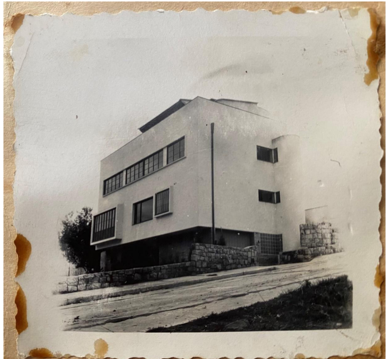
Figura 1. Casa Trujillo estilo art déco, Chapinero Alto, Bogotá
