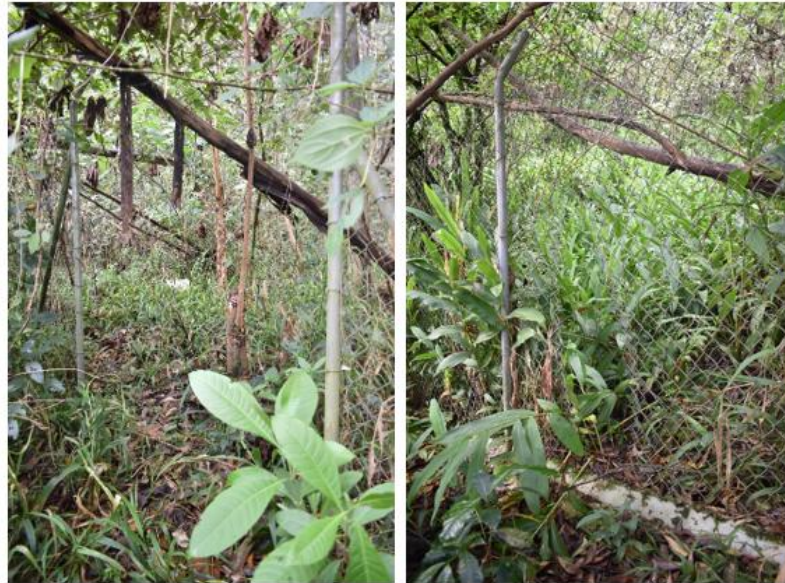
Figura 39. Estado de malla en Seminario Portal Occidente
