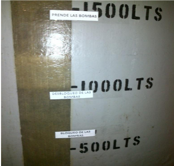
Figura 8. Señalización de acciones de los flotadores.
