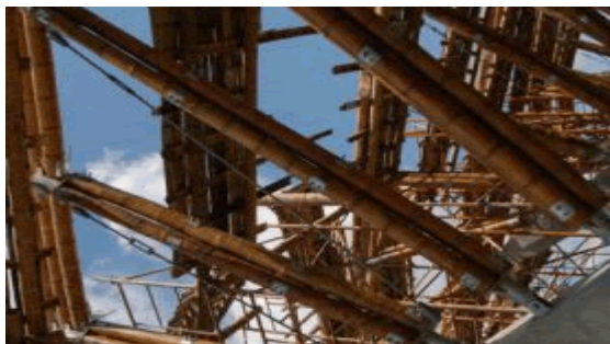
Ilustración 11 Construcción de un peaje en guadua
