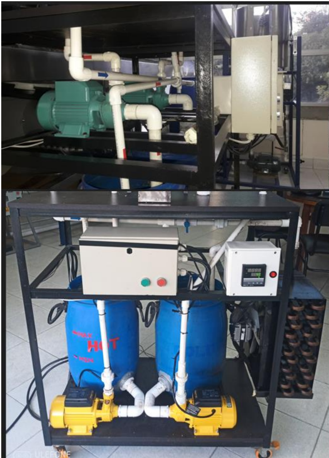
Figura 24. Modificación de posición de bombas de alimentación. Fuente: propia
