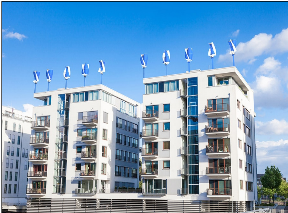
Figura 10. Aerogeneradores verticales instalados en hoteles. Fuente: (AEOLOS, 2017).
