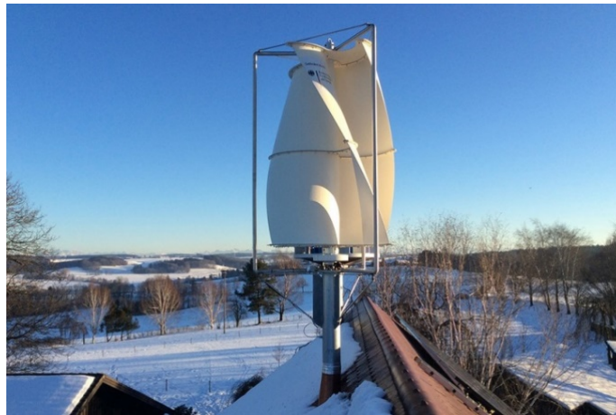
Figura 23. Turbina eólica vertical de 1 kW. Fuente: (Luvside, 2015).
