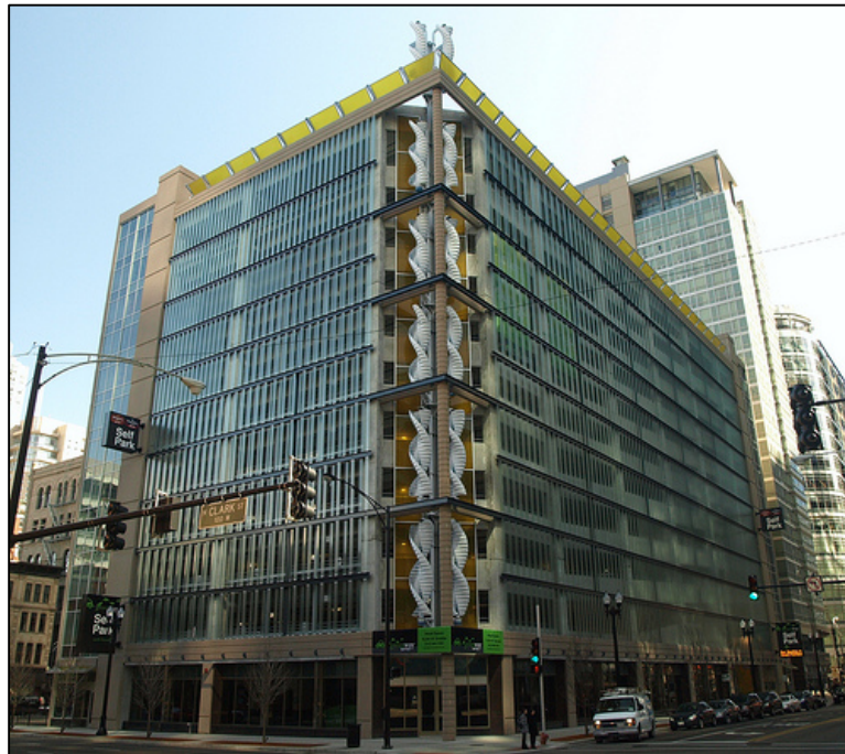
Figura 12. Aerogeneradores verticales en edificios. Fuente: (AEOLOS, 2017).
