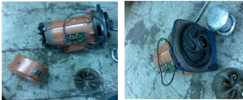
Figura 26. Mantenimiento bomba centrifuga trifásica. Fuente: elaboración propia
