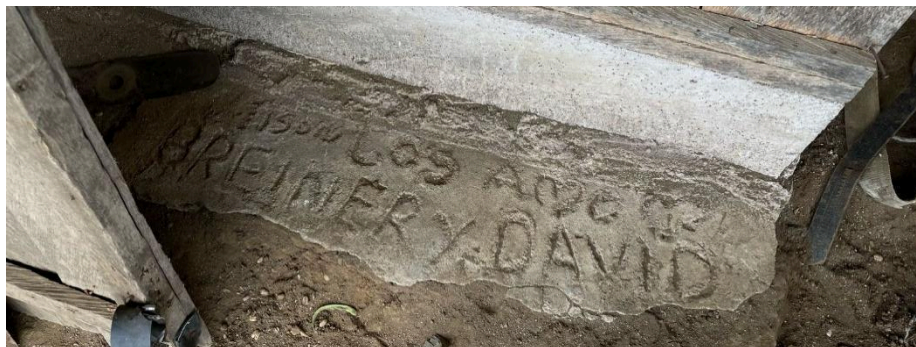
Imagen 24- Pedazo de cemento grabado ubicado en los cimientos de la casa de Diana (2025)
