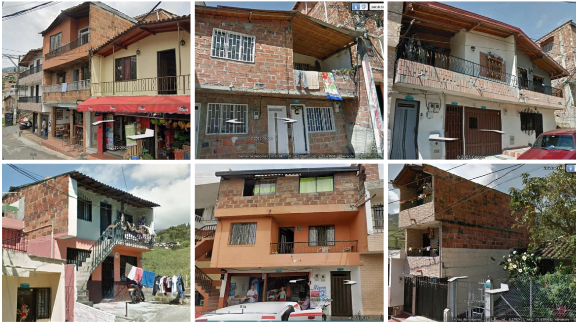
Figura 3-24. Edificaciones presentes en la zona de estudio.
