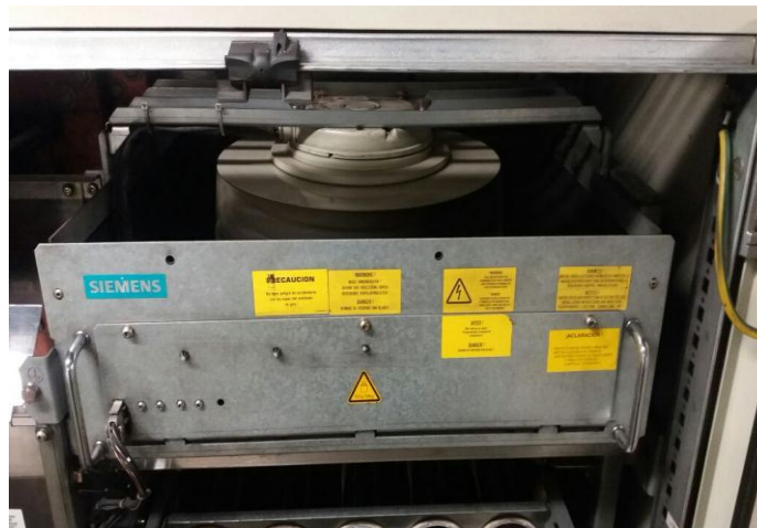
Figura 20. Sistema de ventilación forzada. Fuente: propia.
