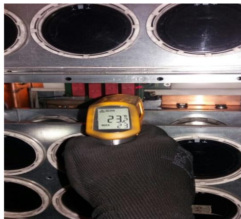
Figura 40. Temperatura de trabajo de la tarjeta sin sistema de ventilación. Fuente: Propia.
