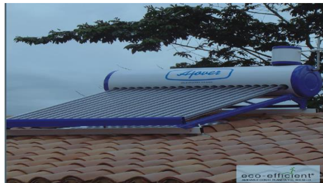
Figura 19. Calentador solar marca Ajoover capacidad de 150 L/día.
