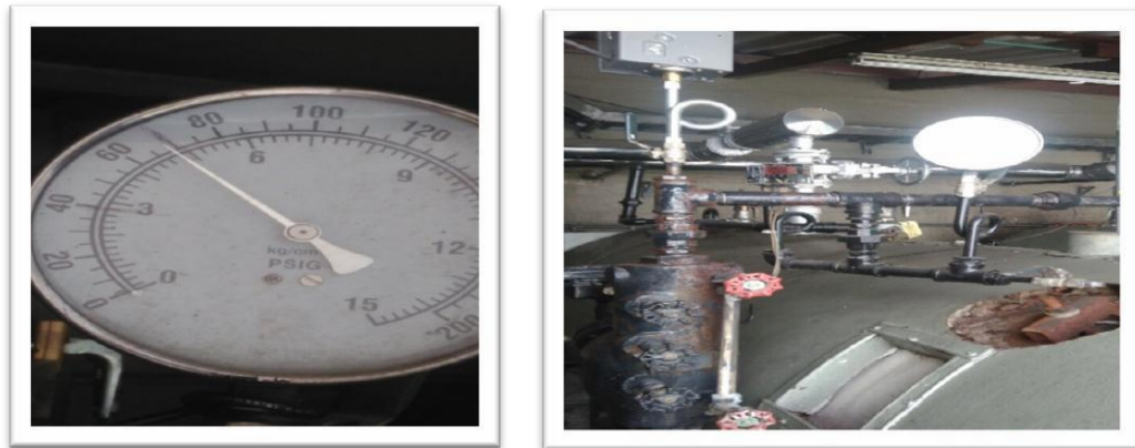
Figura 17. Datos de presión tomados a la salida de la caldera. Fotografía tomada por los autores.
