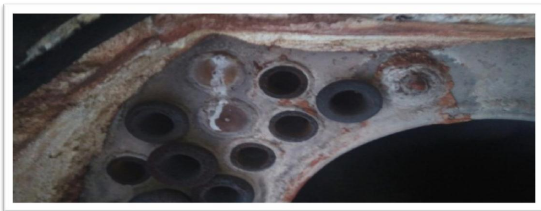
Figura 23. Gráfica de la tubería condenada. Tomada por los autores.
