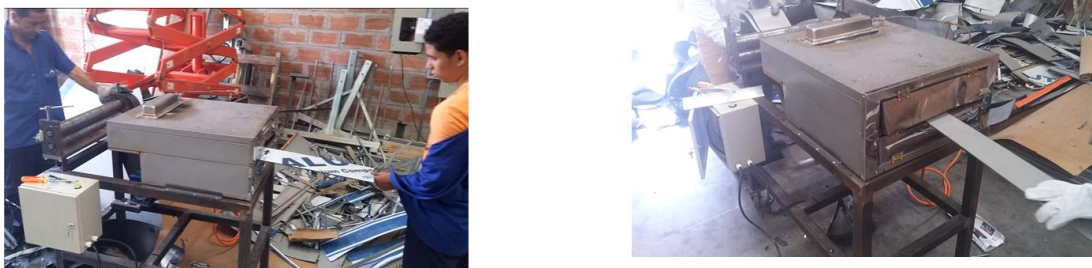
Figura 55. Fotografía entrada lamina de Alucobond (Fuente: Autor).
