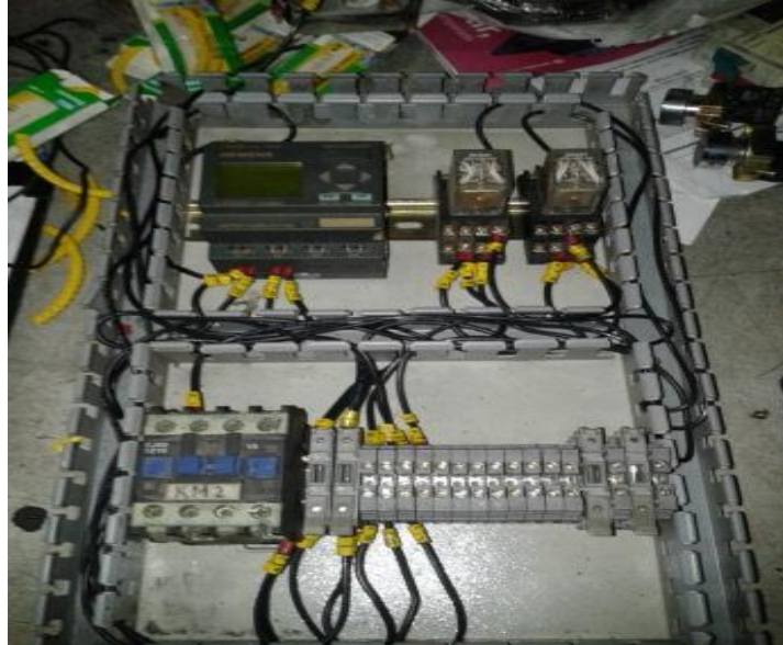
Figura 8. Inicio de cableado para control taladro
