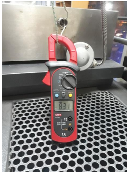
Figura 27. Toma de medida de amperaje (Foto: autores)
