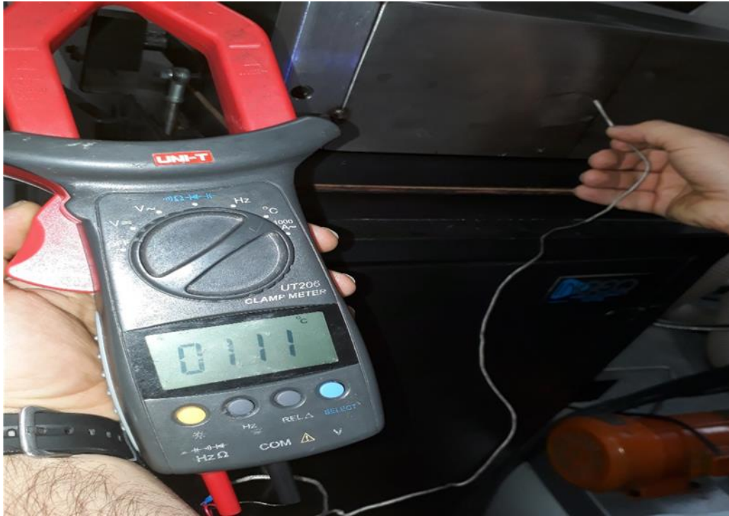
Figura 29. Temperatura tomada en pared metálica de la campana (fuente autores).
