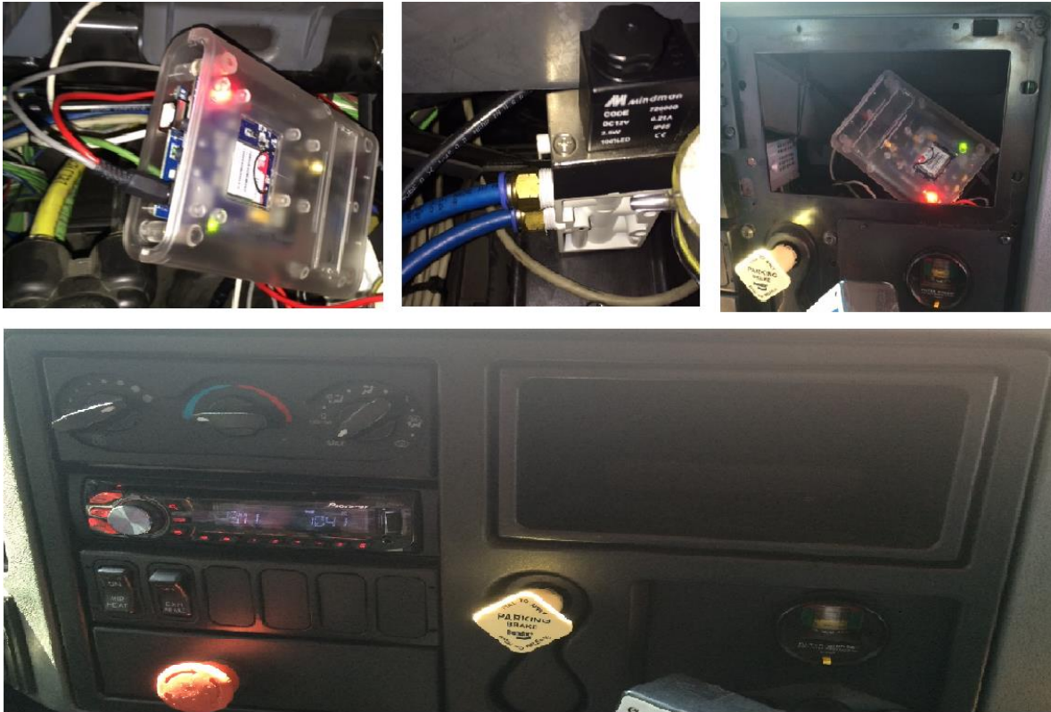
Figura 15. Foto Instalación Sistema de Control
